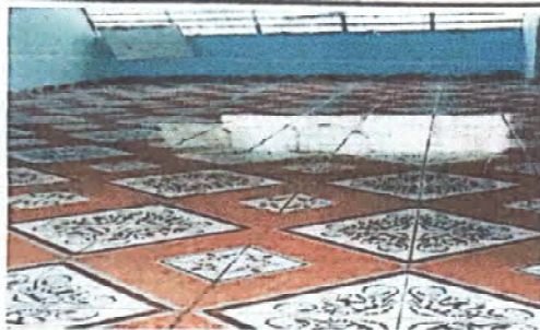
Foto 3: Sustitución de piso a cerámico
