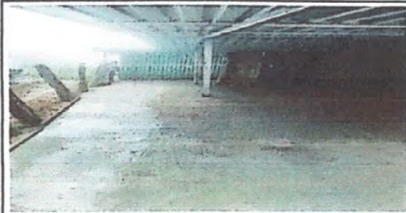
Foto 6: Sustitución de lámina troquelada aluzing
